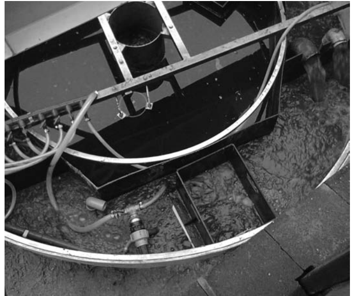
Stav ČOV po zapracování
